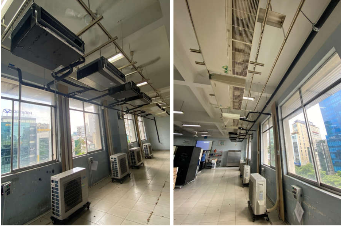
Hình 1. Mô hình hệ thống ĐHKK Skyair bố trí trong phòng F4.2
