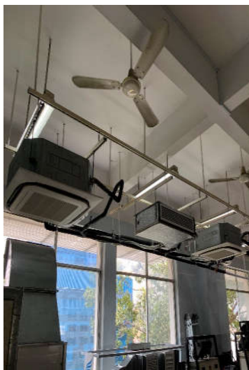
Hình 01. Hệ thống điều hòa không khí trung tâm VRV IIIQ.
