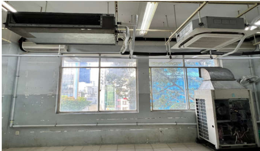
Hình 1. Mô hình hệ thống ĐHKK trung tâm VRV IIIQ
