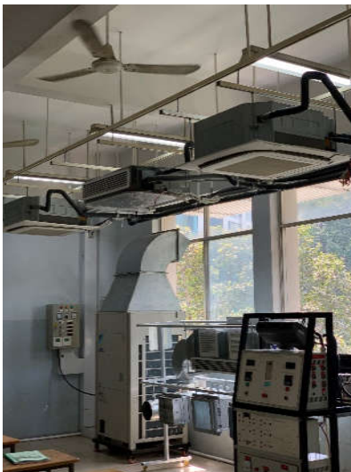
Hình 01. Hệ thống điều hòa không khí trung tâm VRV IIIQ.
