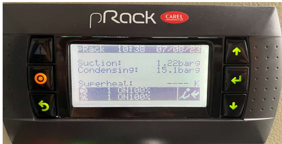
Hình 2. Màn hình PRACK hiển thị các thông số khi đang vận hành
