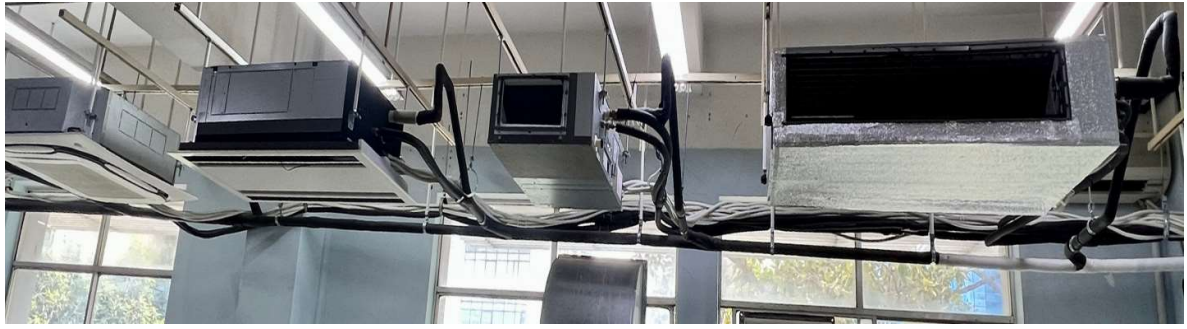
Hình 2. Cụm dàn lạnh ĐHKK VRV IIIQ bố trí trong phòng F4.10B
