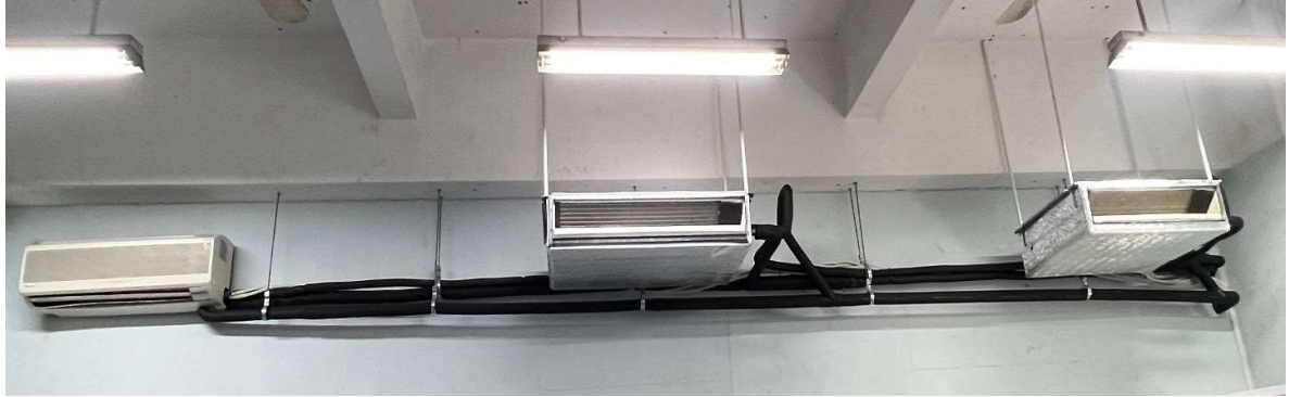
Hình 3. Cụm dàn lạnh ĐHKK VRV IIIQ bố trí trong phòng F4.10A
