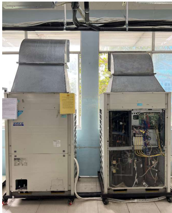
Hình 1. Cụm dàn nóng ĐHKK VRV IIIQ bố trí trong phòng F4.10B
